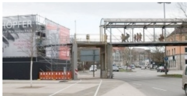
Derzeit kann man neben dem „Stummelsteg“ zwischen Spinatschachtel und Stadthalle auch noch den ebenerdigen Fußgänger-Überweg bei der GWG (rechts) benutzen. Der fällt wegen des GWG-Neubaus bald weg.
