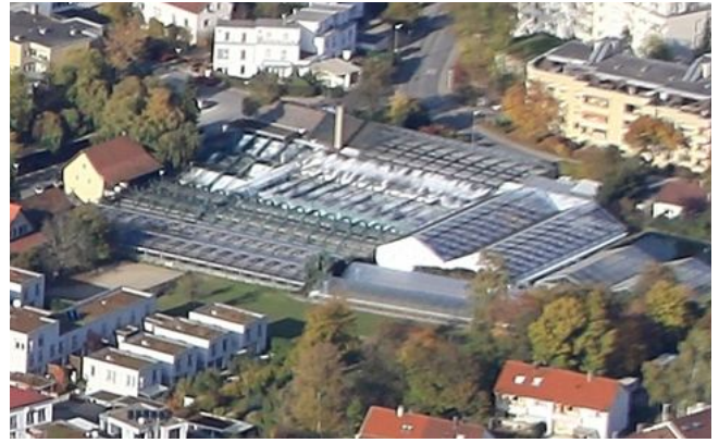
Jetzt ist der Knopf dran: Auf dem Gelände der ehemaligen Gärtnerei Bihler werden Wohnungen gebaut.
